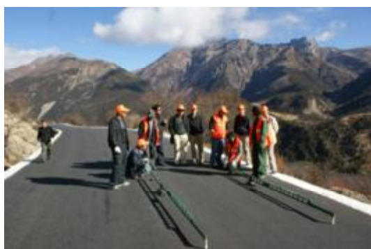
学生参建的道路工程施工检测现场
