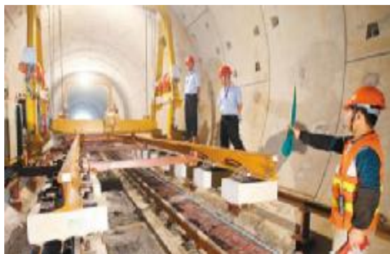
学生参建的地铁施工现场
